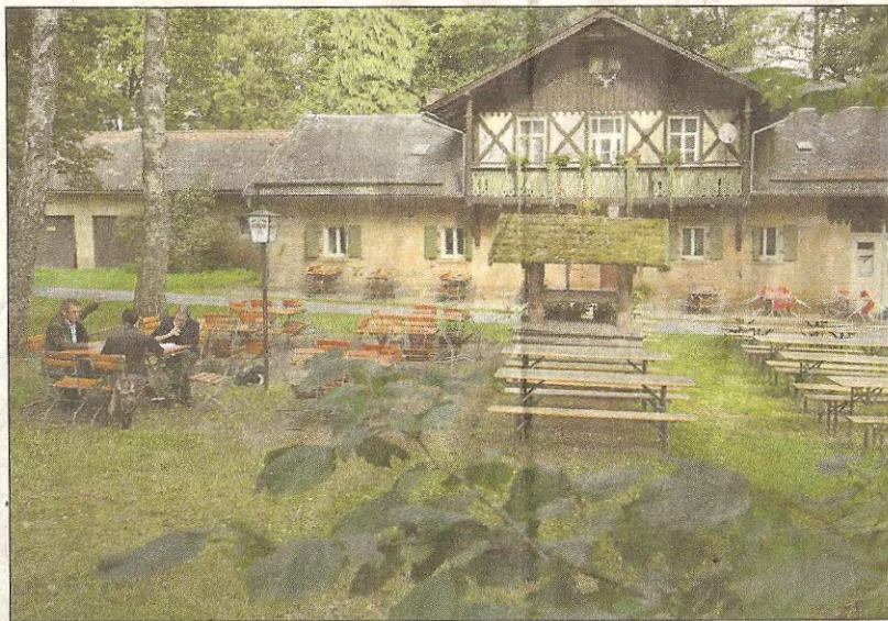
Für etwa ein Jahr wird die Waldhütte im Staatswald bei Eckersdorf ab Oktober wegen Renovierungsarbeiten geschlossen.
